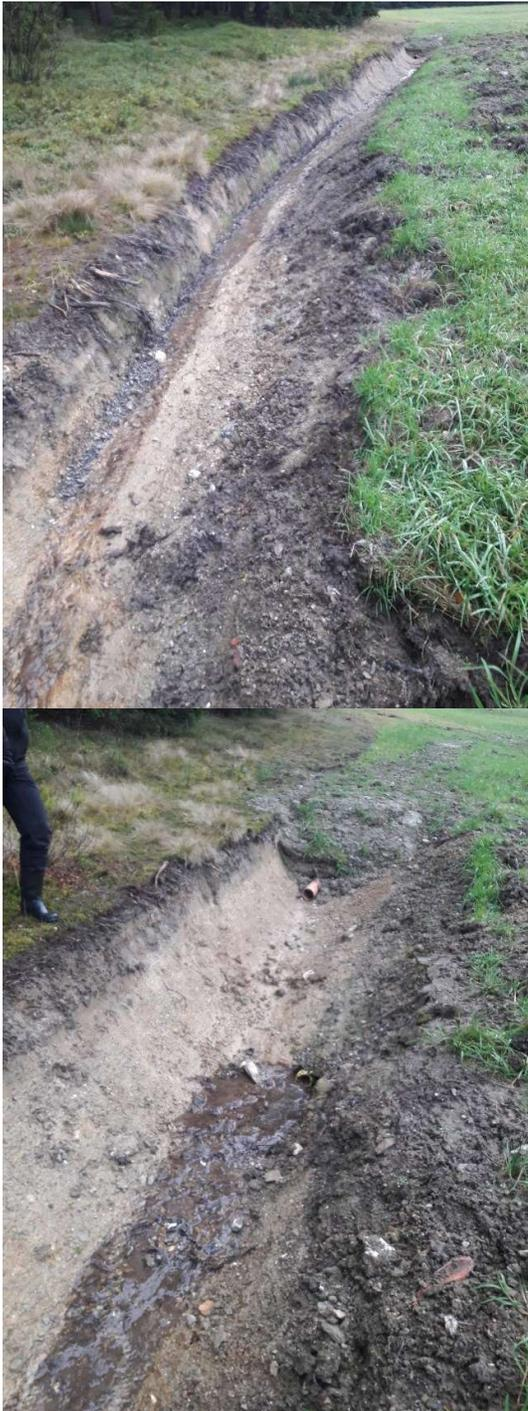
Obrázek 16, Obrázek 17 Neu ausgebaggerte Entwässerungsrinnen an Quellenstellen Luz 32 a 33.
