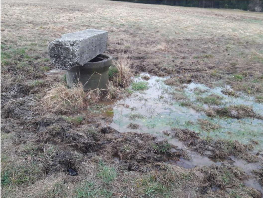
Obrázek 8 Ein offener Schacht des Entwässerungssystems im Gewässer von Rokytnice im Frühjahr 2022. Das Wasser entspringt an der Beschädigungsstelle der Drainage und bildet eine sekundäre Quelle in der Geländesenke, wo wahrscheinlich eine Rinne aus der ursprünglichen Quelle führte. Der obere Teil des Entwässerungssystems ist funktionsfähig.
