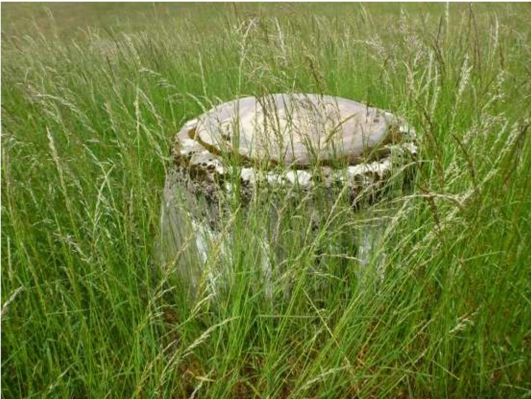
Obrázek 10 Schacht des unterirdischen Hauptentwässerungssystems, Gewässer Lužní potok/ Zinnbach
