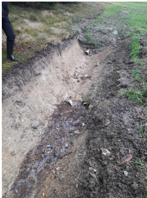
Obrázek 15., Obrázek 16. Nově vybagrované odvodňovací strouhy v místech pramenišť Luz 32 a 33.
