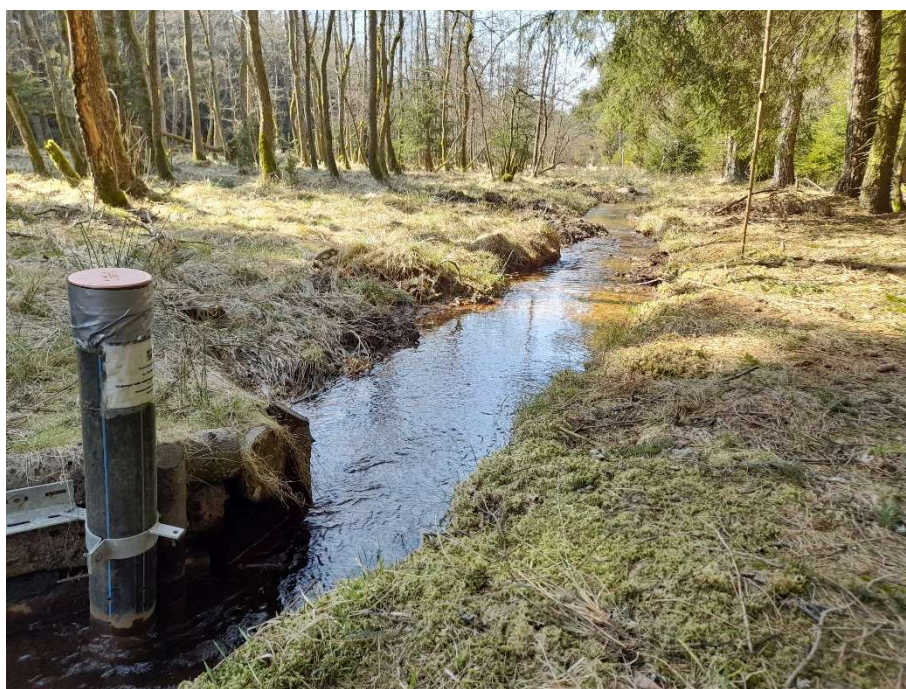
Obrázek 22. Vodoměrná stanice Pekelský potok
