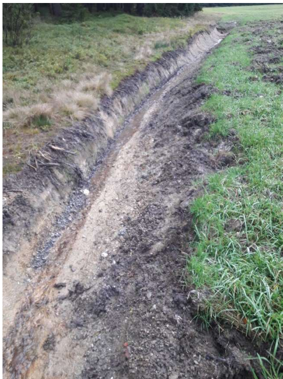
Obrázek 15., Obrázek 16. Nově vybagrované odvodňovací strouhy v místech pramenišť Luz 32 a 33.
