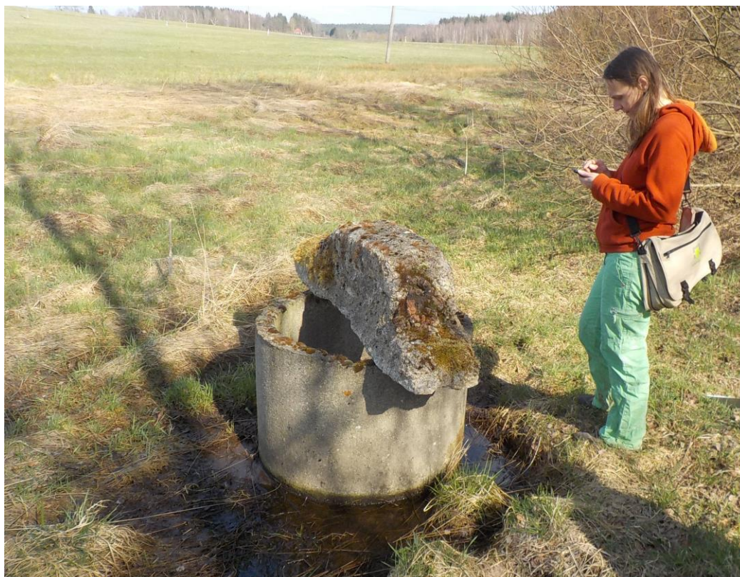
Obrázek 14 – Meliorační skruž v povodí Rokytnice
